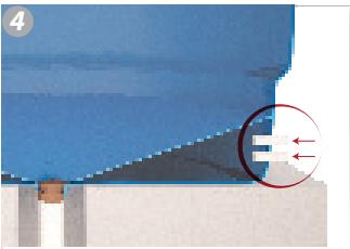
4. Encher o calço hidráulico (lateral inferior) das caixas de 2.000ℓ ou mais seguindo os passos 5, 6 e 7. Somente depois desse procedimento encher a caixa por completo.
