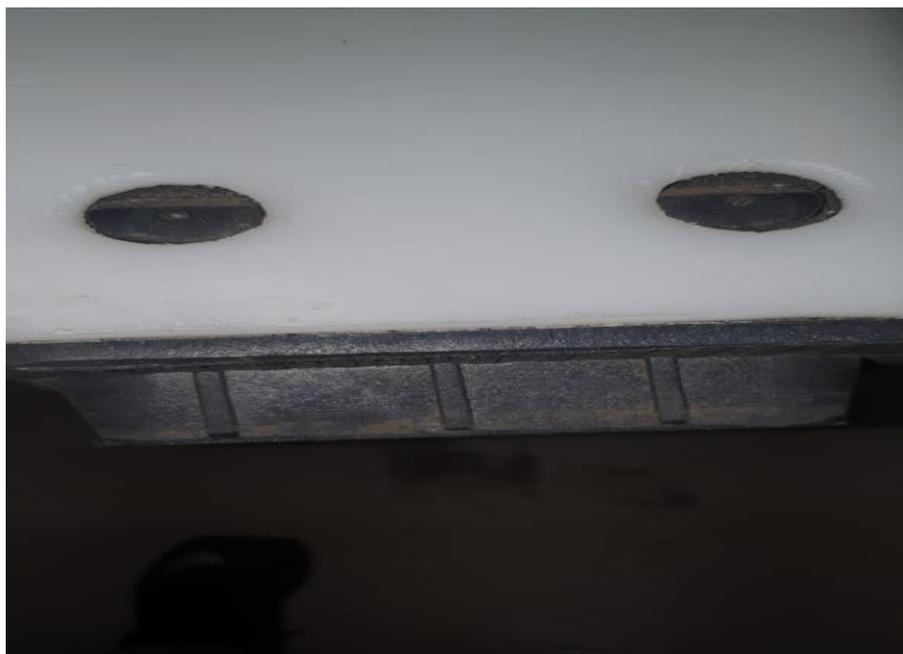
Foto 05 – Travas dos pés nas laterais do contêiner para fixação.
