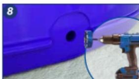
8. Utilize a ferramenta serra-copo compatível com os flanges de entrada, de saída, do extravasor (ladrão) e de limpeza.
