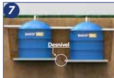
7. Utilizar traço de cimento: terra (1:10), livre de pedras ou objetos pontiagudos e efetuar a compactação a cada 25cm. O processo de aterramento e compactação não deve ser mecanizado.
