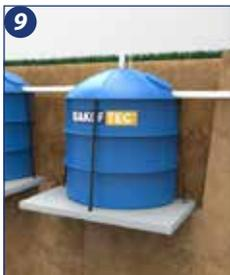
9. Em terrenos arenosos, movediços e lençóis freáticos superficiais, além da base, realizar ancoragem do sistema.
