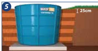
**5.** Utilizar terra peneirada (livre de pedras e objetos pontiagudos), areia ou pó de brita, adicionados a cimento ao traço de 1:10, como aterramento e efetuar a compactação manual a cada 25cm. O processo de aterramento e compactação não deve ser mecanizado.
