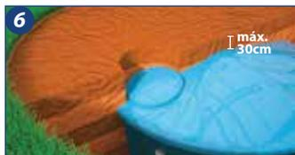
**6.** Preservar fácil acesso à tampa de inspeção para eventual manutenção e limpeza. Não deve haver aterro sobre a tampa de inspeção, sobre o equipamento o máximo de 30 cm.
