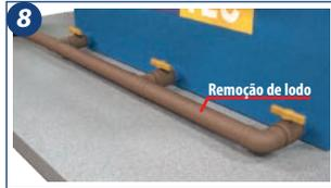
8. A tubulação existente na lateral inferior do equipamento servirá para a remoção de lodo que poderá acumular no fundo do tanque. Os registros deverão ser mantidos fechados, devendo ser abertos apenas para a realização da limpeza.
