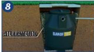
8. Realizar o aterramento lateral do equipamento utilizando terra (livre de pedras ou objetos pontiagudos), areia ou pó de brita adicionadas a cimento com traço de 1:10 (uma parte de cimento para 10 partes de areia) e efetuar a compactação a cada 25 cm. Não devem ser utilizadas máquinas para aterramento.
