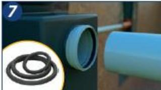
7. Utilizar anéis de vedação para realizar as conexões de entrada e saída de efluente (que deverá ser direcionado a um sumidouro, vala de infiltração ou rede coletora). Instalar a tubulação e o registro de remoção do lodo. Manter o registro fechado.
