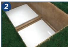
2. Construir uma base nivelada e lisa em concreto armado que servirá como apoio para os Retator e Biofiltro Bakof Tec.
