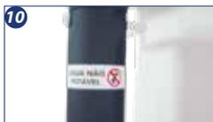
**10.** Os pontos de consumo que utilizarem água da chuva deverão estar identificados como "água não potável", segundo a NBR 15.527. De acordo com a NBR 5.626, o sistema de distribuição de água da chuva deve ser independente do sistema de água potável.
