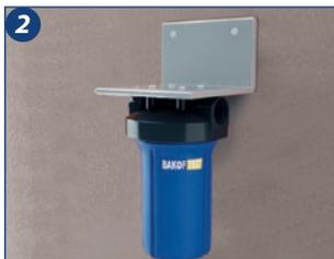
2. Dimensione o local da instalação onde ficará o suporte do filtro (o suporte é vendido separado da carcaça). Selecione o tubo de entrada da água. Observe a posição em que o filtro será instalado para dimensionar o espaço necessário.
