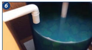
**6.** A Bakof Tec oferece o sistema de tratamento de efluentes sanitários completo, já incluindo anéis plásticos. Caso a sua aquisição foi o Filtro Bakof Tec, o mesmo deve ser preenchido com meio filtrante plástico ou pedra brita nº 4 ou 5.
